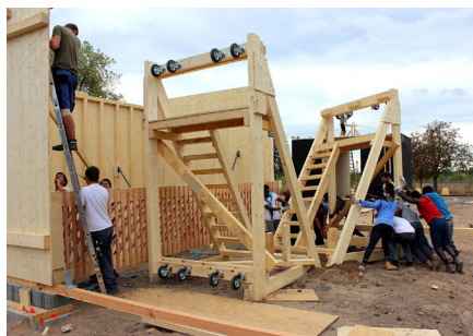
Selbstgebaute Hilfskonstruktionen auf der Baustelle
