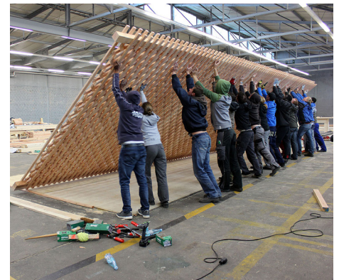
Vorbereitung der östlichen Gitterwand in der Werkstatt
