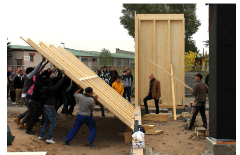
Aufstellen eines Holzrahmenbauelements
