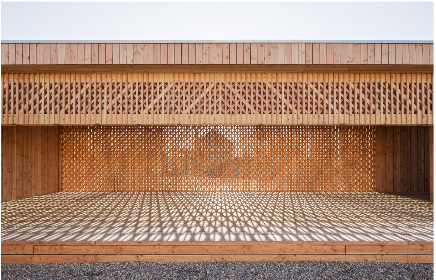
(1) Gemeinschaftsraum und Bühnenplattform für Veranstaltungen mit Gitterwand nach Süden
