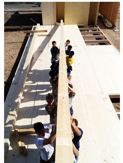
Montage des Untergurts für den grossen Fachwerkträger
