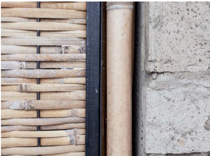
Fügung Randstütze / Türe
